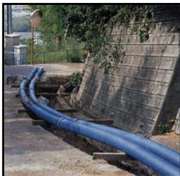
写真① 参考工事写真
