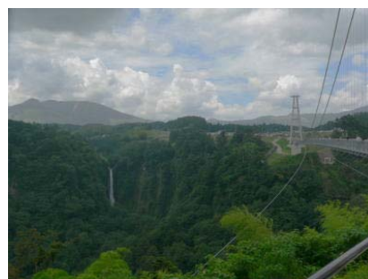
写真2：九重“夢”大吊橋
